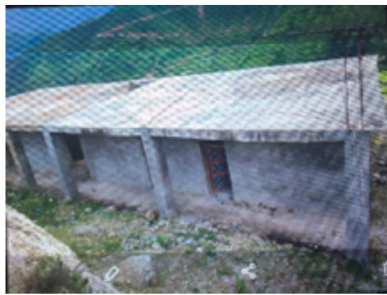
चित्र १: निर्मित ४ कोठे भवन
