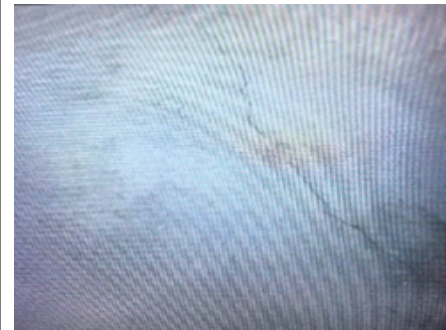
चित्र ४: भवनको छेउपट्टिको पर्खाल चिरा परेको
